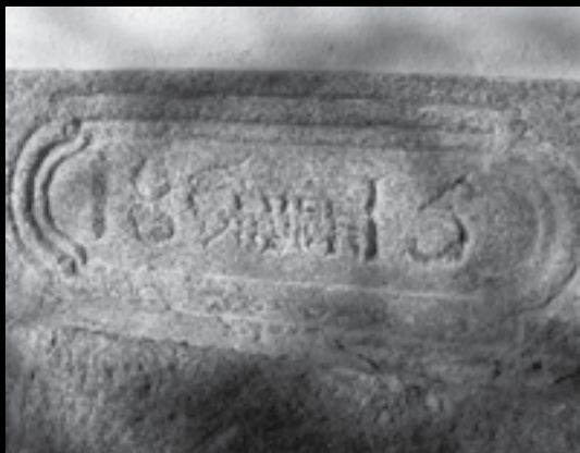
Kamenná deska s letopočtem 1815 na budově synagogy.
