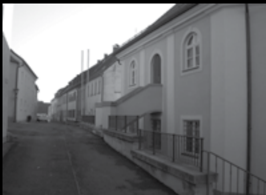
Synagogu s nápadně žlutou fasádou najdeme v hlavní ulici židovské čtvrti.
