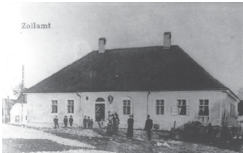
Stará budova celnice v obci Rozvadov na dobové fotografii. Celnice fungovala až do roku 1945.
